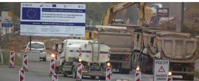
Začátek stavby 0308 C
