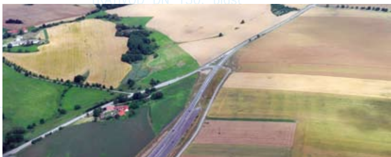
Provizorní ukončení D3 u Nové Hospody
