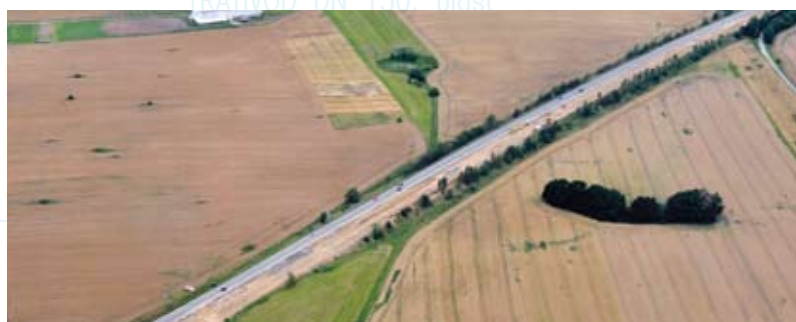
Probíhající rekonstrukce čtyřpruhu na obchvatu Táboru
