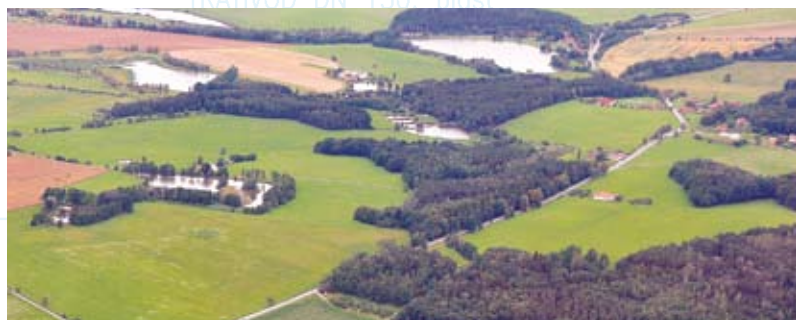
Silnice I/3 u Bukovce
