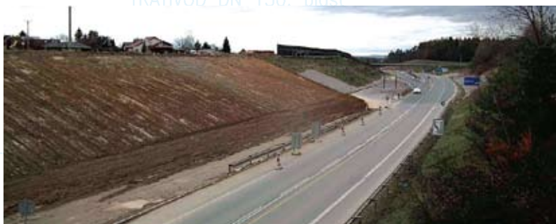
Práce na rozšíření stávající silnice na dálnici
