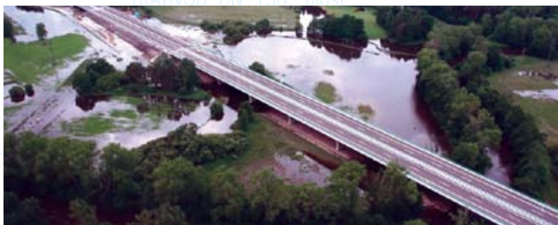
Most přes Lužnici a inundační most
