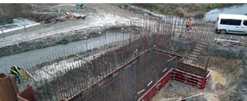
Zakládání mostu pro rozšíření silnice I/3
