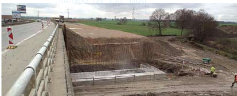
Zakládání mostu pro rozšíření silnice I/3
