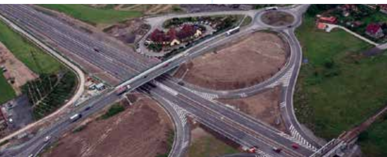
MÚK Měšice (exit 79)
