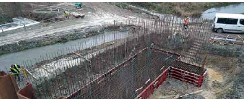
Zakládání mostu pro rozšíření silnice I/3
