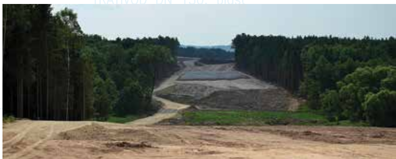
Km 128,9 směr ČB – budoucí most přes Kyselou Vodu
