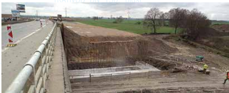
Zakládání mostu pro rozšíření silnice I/3
