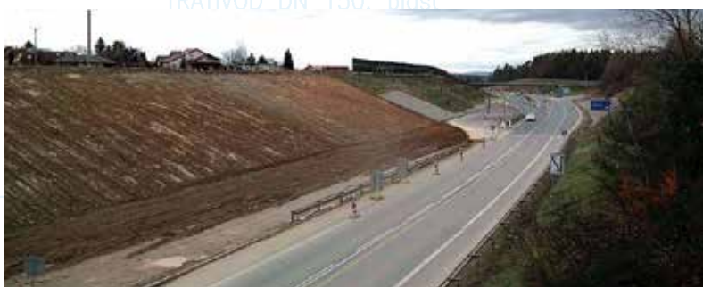
Práce na rozšíření stávající silnice na dálnici
