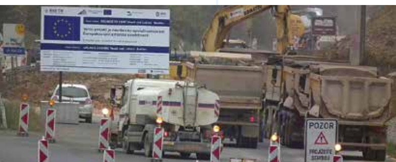
Začátek stavby 0308 C
