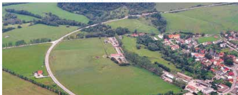
Silnice I/3 na obchvatu Dolního Dvořiště
