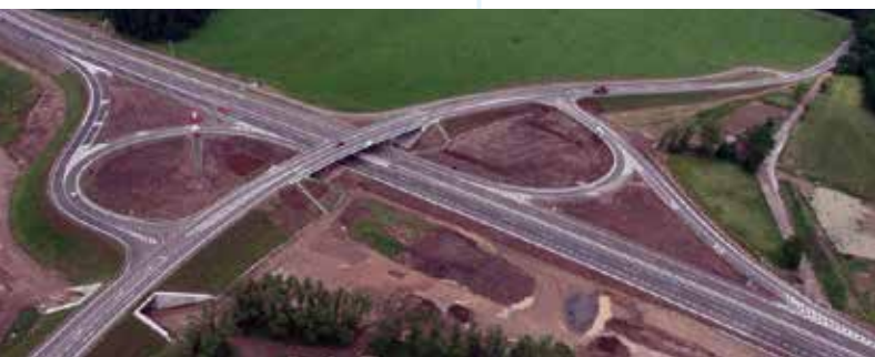
MÚK Planá nad Lužnicí (exit 84)
