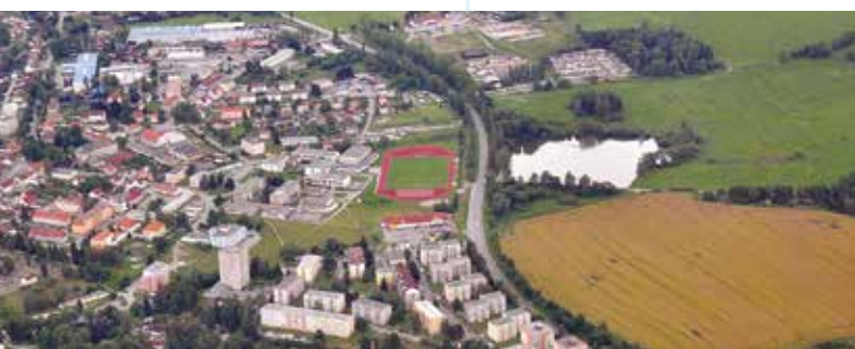
Kaplice, současná silnice I/3
