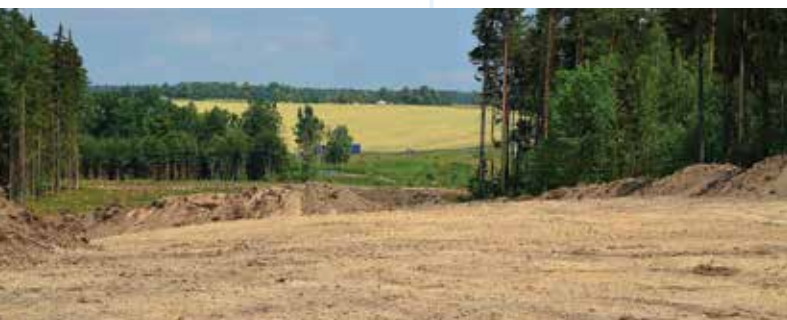
Km 128,5 směr ČB – lesní průsek na začátku stavby
