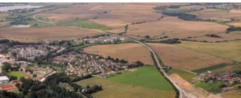
Celkový přehled stavby 0308C
