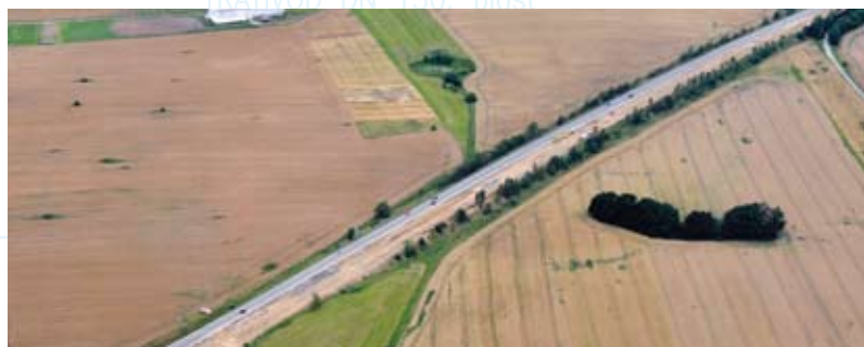
Probíhající rekonstrukce čtyřpruhu na obchvatu Tábora
