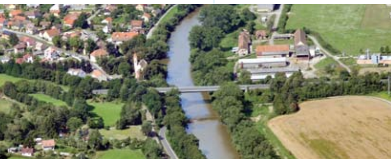
Stávající most přes Sázavu na silnici I/3
