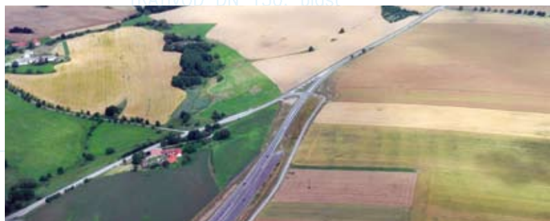
Provizorní ukončení D3 u Nové Hospody
