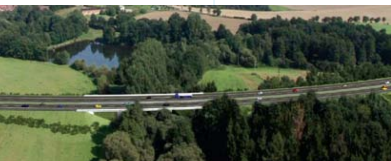
Most přes potok Mastník u Nových Dvorů
