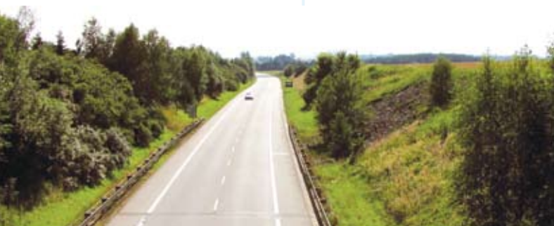
Současná silnice I/3 na obchvatu Veselí nad Lužnicí
