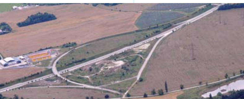
Místo budoucí MÚK Úsilné s čtyřpruhovou silnicí I/34
